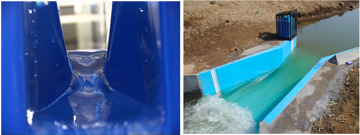
FIGURE 3.4 – Exemple de venturi ou "Parshall flume"
